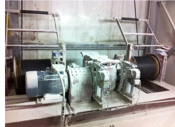
Abb. 1: Skipwinde an einem Maerz-Ofen mit Standard-Asynchronmotor 37 kW, 4.pol.
