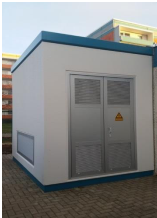
Abb. 1 Transformator-Trockenbetonstation
